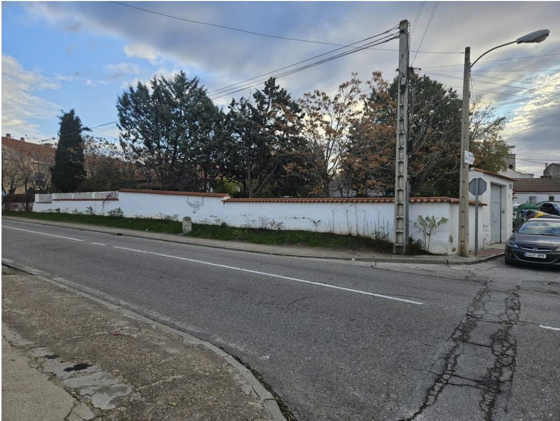
Vista desde esquina Calle la Tercia con Calle Madrid
